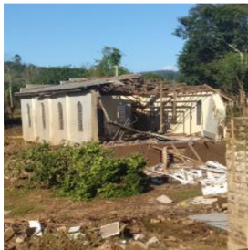
Rastros de destruição em uma igreja no interior do estado
